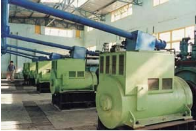
福建省莆田華港米業の1000KWの籾ガス化発電所
